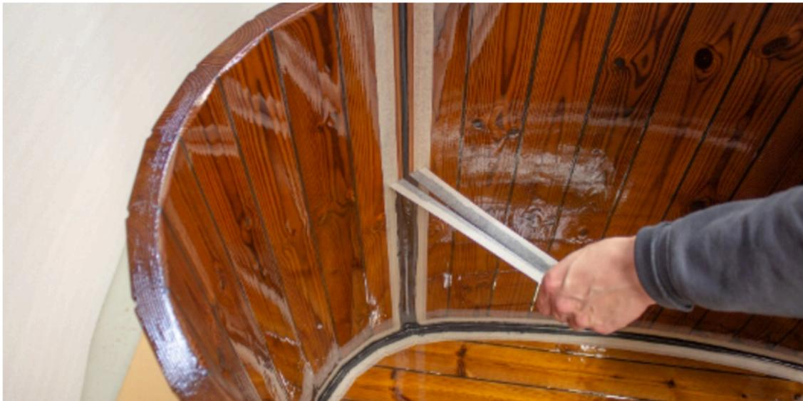
Entfernen Sie das Abdeckband und lassen Sie die Nähte mindestens 12 Stunden trocknen.
