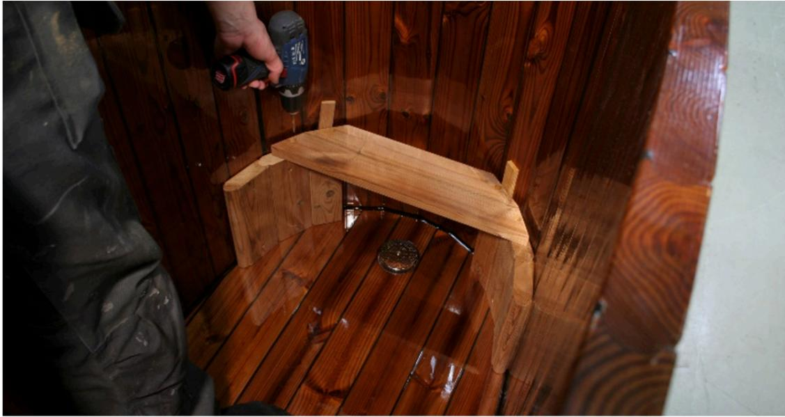
Bohren Sie mit einem 3-mm-Bohrer vor und schrauben Sie den Sitz mit vier Schrauben fest. Vergessen Sie nicht, die mitgelieferten Unterlegscheiben zu verwenden!
