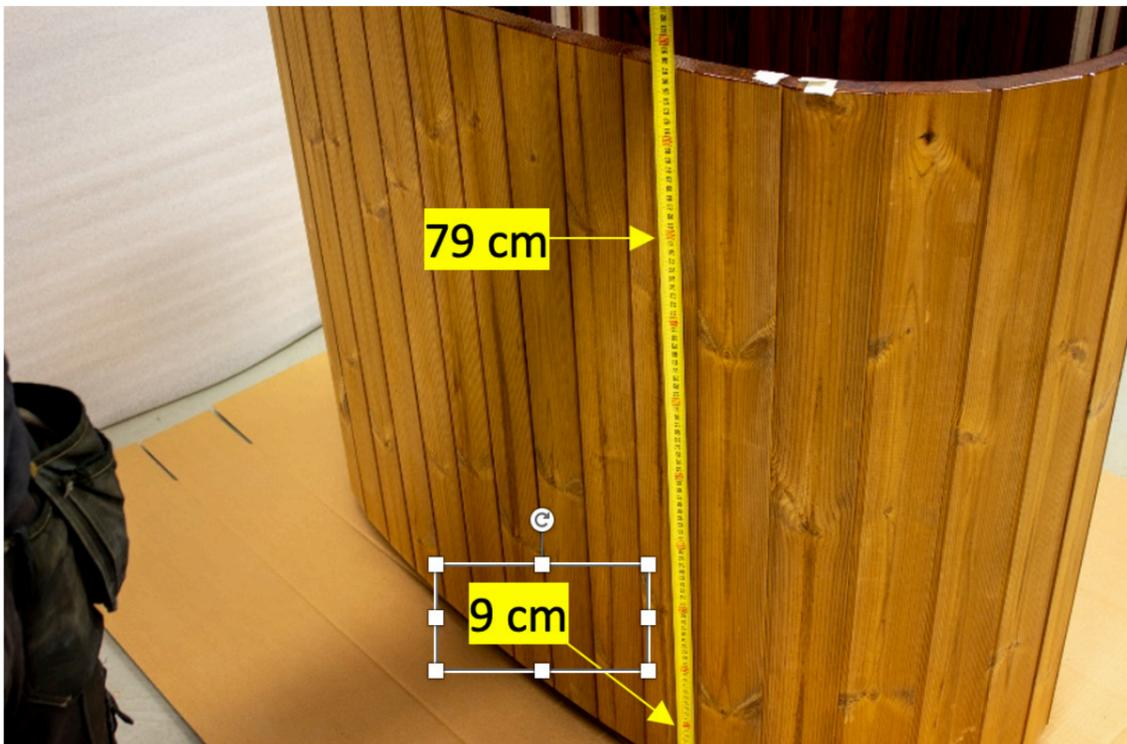
Bringen Sie Stütznägel (Stiftnägel) für die Edelstahlbänder in jeder Ecke des Whirlpools an. Messen Sie 9 und 79 cm von der Unterseite des Seitenmoduls. Dies dient dazu, dass die Bänder gleichmäßig angebracht werden können.
