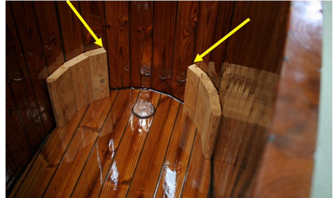
Platzieren Sie die erste Stütze an der durch den Pfeil angezeigten Stange. Bohren Sie mit einem 3-mm-Bohrer vor und schrauben Sie alle Teile in die Seiten. Siehe Bild auf der letzten Seite für weitere Details.
