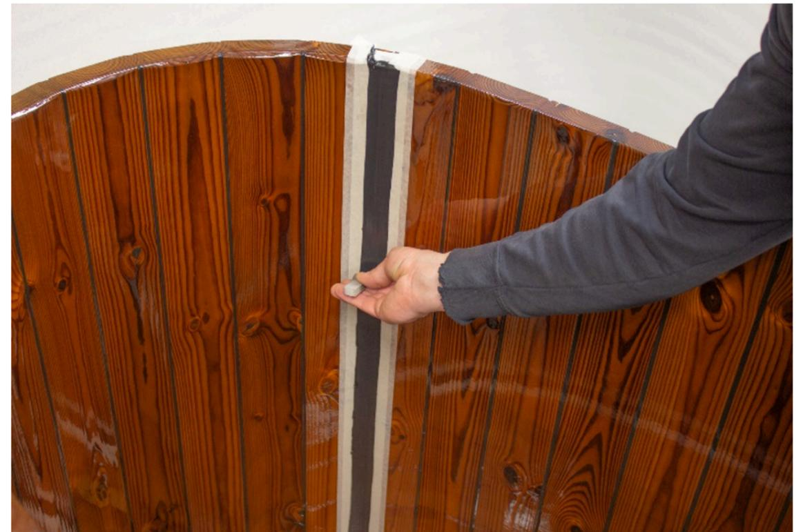
Die Dichtmasse in der unteren Naht mit einem Spachtel ausstreichen
