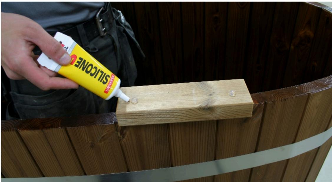
Montage des Sitzes. Verwenden Sie Silikon in den Löchern, bevor Sie sie anbringen. Auf diese Weise stellen Sie sicher, dass kein Wasser in das Loch eindringt, welches durch die Schraube entsteht.
