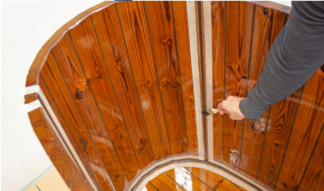
Tragen Sie TubCoat auf die Nähte im Boden und an den Seiten auf.
