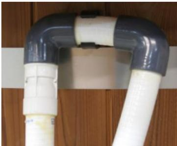
Der Schlauch läuft an der Seite des Hottubs hoch, so das kein Wasser in die Luftpumpe eindringen kann.
