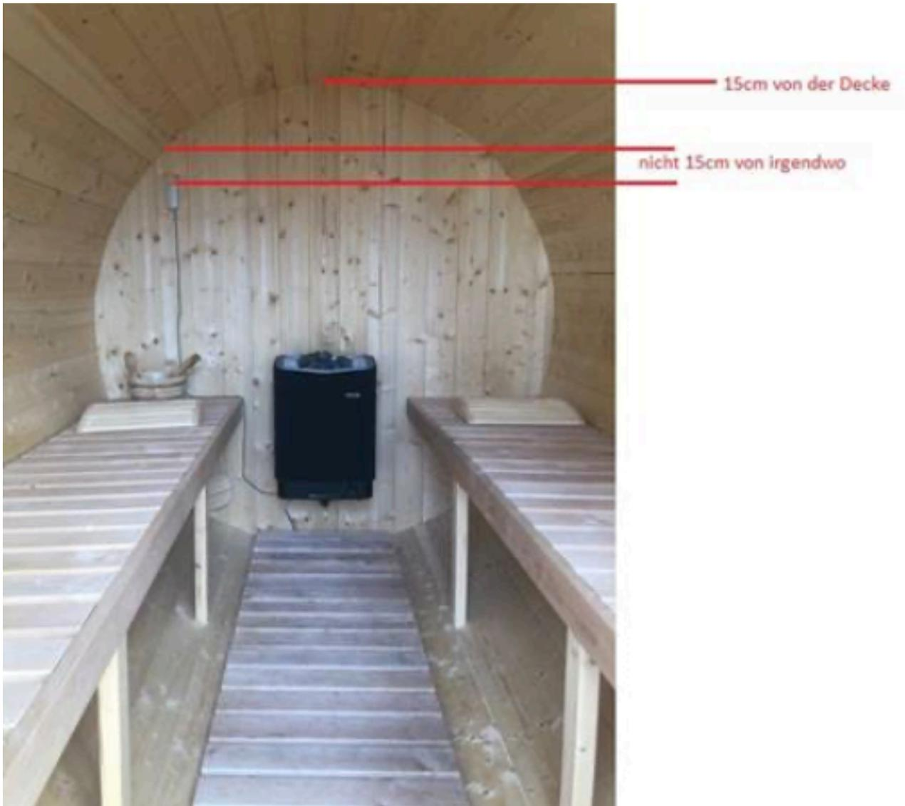
STEUERGERÄT Weiterhin darf das Steuergerät mit der Oberkante nicht höher als 90 cm vom Boden sitzen. Es kann Temperaturen bis max 70°C vertragen.
