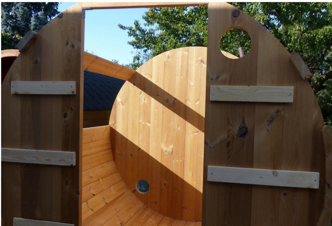
**Rückwand:** Das Lüftungsloch muss nach UNTEN (Montagehilfsbretter somit außen)
